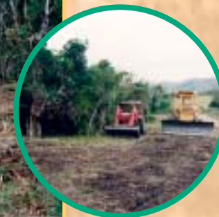
Engins dégageant les traces de la future clôture sur le site de Tiéa © J. Manaute-DDE-E
